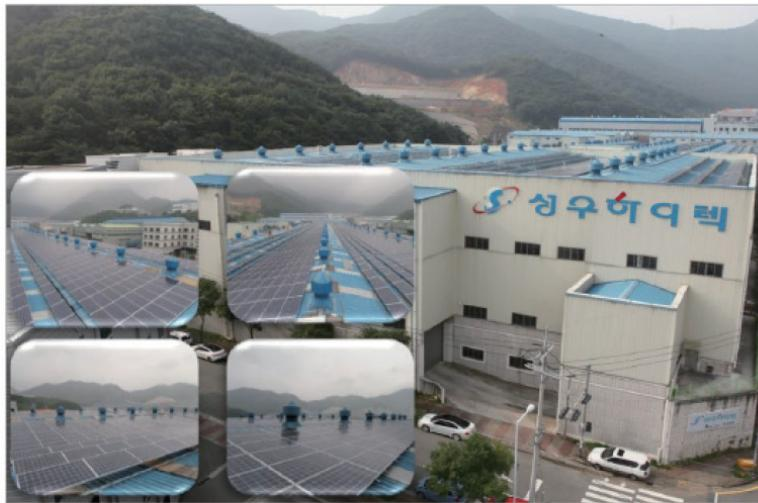
5월 29일 부산KBS1Radio <굿모닝 부산>은 성우하이텍 지사공장에서 운영하는 태양광 발전에 대하여 보도하였다. 성우하이텍은 2014년 9월부터 자체사업으로 태양광 발전을 가동하여 연간 360여 가구가 1년간 사용할 수 있는 전기량을 생산하고 있다. 지사공장 옥상에 설치한 태양광 발전 시설은 에너지 절감, 임대수익, 지붕유지관리의 일석삼조의 효과가 있다. 태양광 모듈 3,330개를 통해 생산되는 전기량은 시간당 999.6KW에 달하여, 향후 5년 내 설치비용을 모두 회수하고 순수익으로 돌아설 것으로 예상된다.
