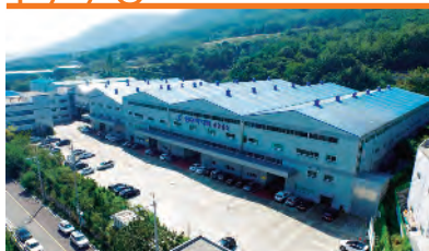
금형공장(경남 양산시 소주동) Stamping Mold Factory(Sojugongdan, Yangsan-si, Gyeongsangnam-do)
